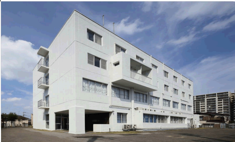
2011年耐震補強工事・2014年外壁塗替工事等・2015年寮室等改装工事終了
