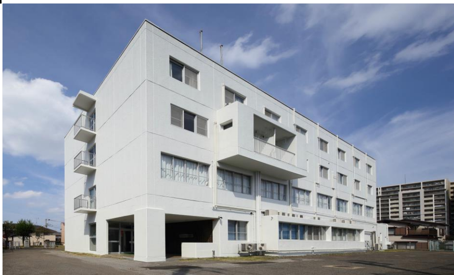
2011年耐震補強工事・2014年外壁塗替工事等・2015年寮室等改装工事終了
